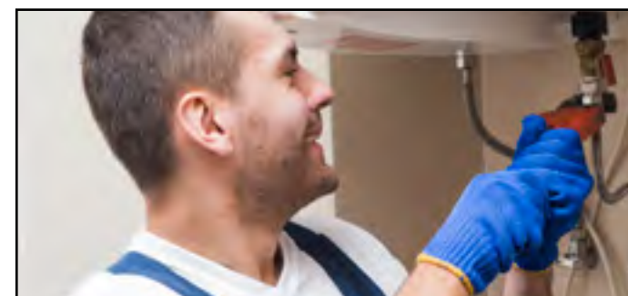
Se debe realizar mantenimiento permanente a las redes de agua de la vivienda.
