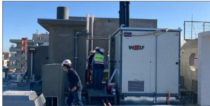
*Sala de calderas prefabricadas alemanas de condensación Wolf, que producen ahorro de energía.*
