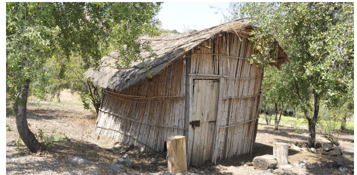
Casa de Quincha, Tilama, Región de Coquimbo
