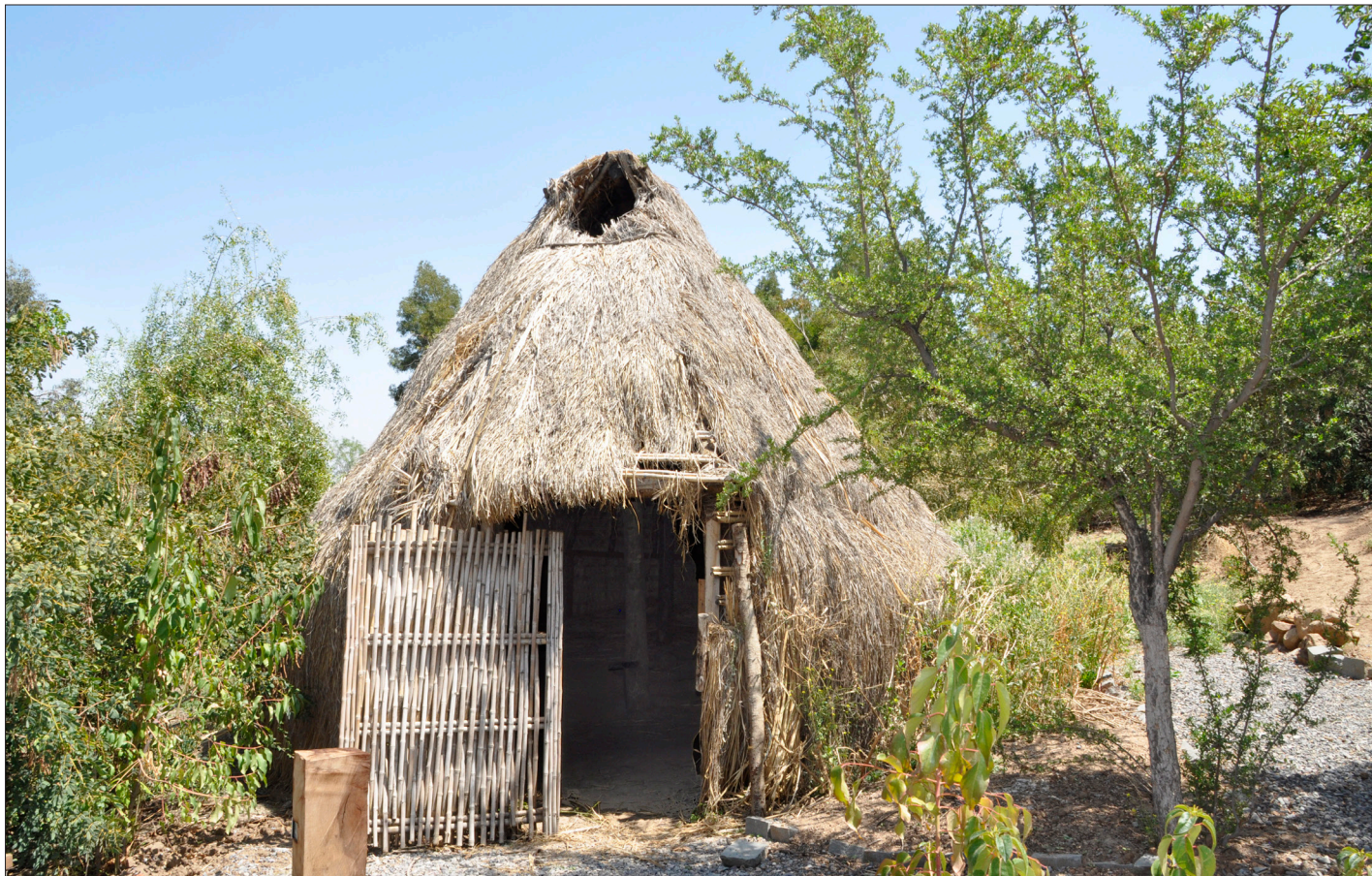
Ruca Traro, lafkenche. Nueva Imperial, Región de La Araucanía. Su techo de paja llega hasta el piso y se confunde con los muros del mismo material.
